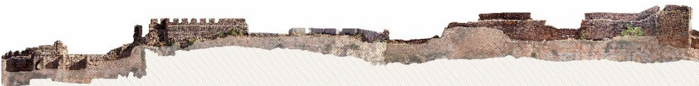
Fig. 7- Alzado interior del lienzo suroeste del conjunto defensivo del Castillo de Sagunto realizado mediante fotogrametría aérea
