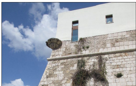
Fig. 14- Bastione di Santa Croce. Dettaglio del parapetto inclinato (2018).
