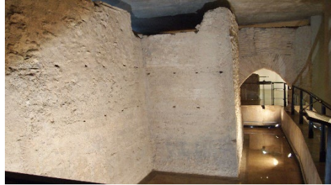
Fig. 7- La muralla árabe de Valencia ubicada en la plaza del Tossal de Valencia.
