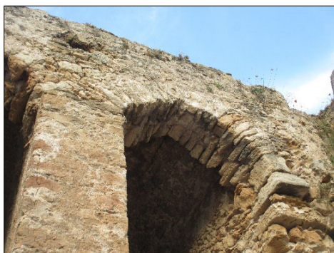
Fig. 11- Bastione della Maddalena. Dettaglio della tecnica costruttiva che prevede una connessione tra setti e archi in muratura (2016).
