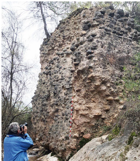
Fig. 1- Vista, aguas abajo, del estribo izquierdo de la presa. Elaboración propia.
